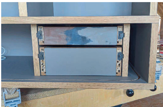
/ Die aus Vollkernplatte gefertigten Vollauszüge der Schubkästen sichern auch bei klimatischen Schwankungen den spielfreien Lauf der Schubkästen aus Lisocore.
